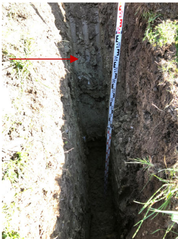
Abb. 2: Verwitterungslehme in SCH2 mit Markierung von Wassereintritt
