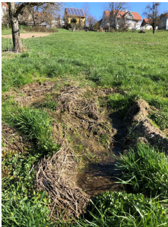
Abb. 4: Quellaustritt an der GOK neben SCH2 (Lage vgl. Anlage 2)
